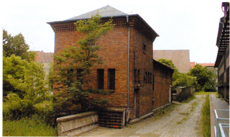
Ehemalige Telefonschaltzentrale der Bewag
